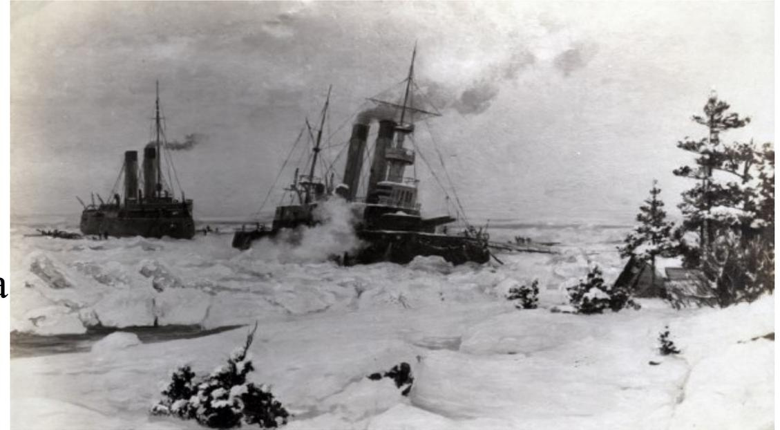
Вода быстро наполнила бы все отделения, причем броненосец, опускаясь кормою на каменистое дно, вероятно, получил бы повреждения в других частях корпуса. Механизмы и прочее, от действия воды и льда, оказались бы попорченными, и весенний ледоход, который у Гогланда, действительно, силен напором на верхнюю палубу, башни и надстройки, усугубил бы повреждения.
